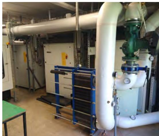
Figura 7 - Pompe di calore e cogeneratore
