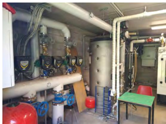
Figura 8 - Dettaglio dei circuiti della Centrale di Teleriscaldamento
