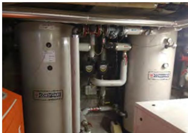
Figura 4 - Dettaglio serbatoi accumulo acqua tecnica
