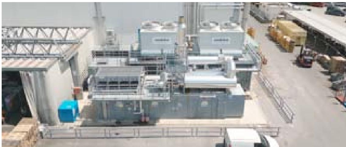
A seguito dell'audit energetico, Centrica Business Solutions ha progettato e finanziato direttamente una soluzione multi-prodotto in grado di integrare l'impianto solare esistente con un impianto di trigenerazione hydrogen-ready da 1,5 MW, i servizi di gestione e manutenzione, il monitoraggio dei consumi mediante sensori wireless Panoramic Power e l'illuminazione a led.
