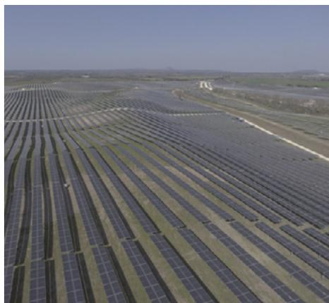
produzione. Il beneficio del bifacciale viene aumentato dall'utilizzo di single axis trackers a due file di pannelli, i quali permettono di avere una rotazione +/- 60 gradi (vs. +/-45 gradi dei tradizionali) massimizzando la produzione e andando a catturare la luce del sole nelle prime ore del mattino e nelle tarde ore della sera.
