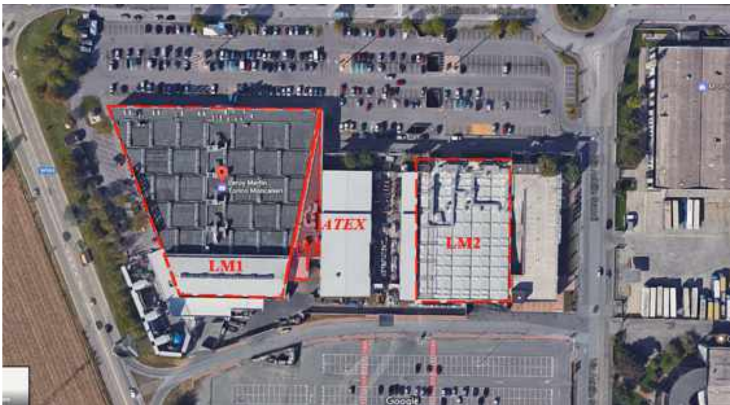
Figura 1 – Aree in cui si articola il punto vendita: vista aerea
