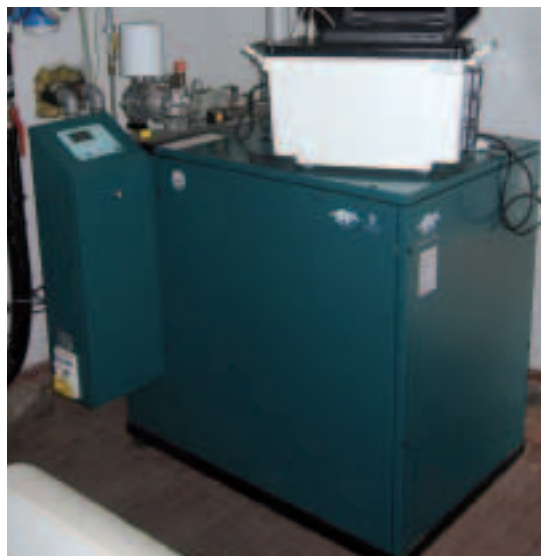
Figura 1. Micro-cogeneratore Senertec DACHS
