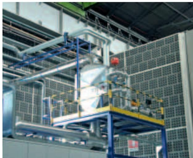
calore viene generato per via delle irreversibilità del processo elettrochimico e in parte recuperato per mezzo di uno scambiatore che ne trasferisce la potenza termica all'acqua del circuito di riscaldamento.
