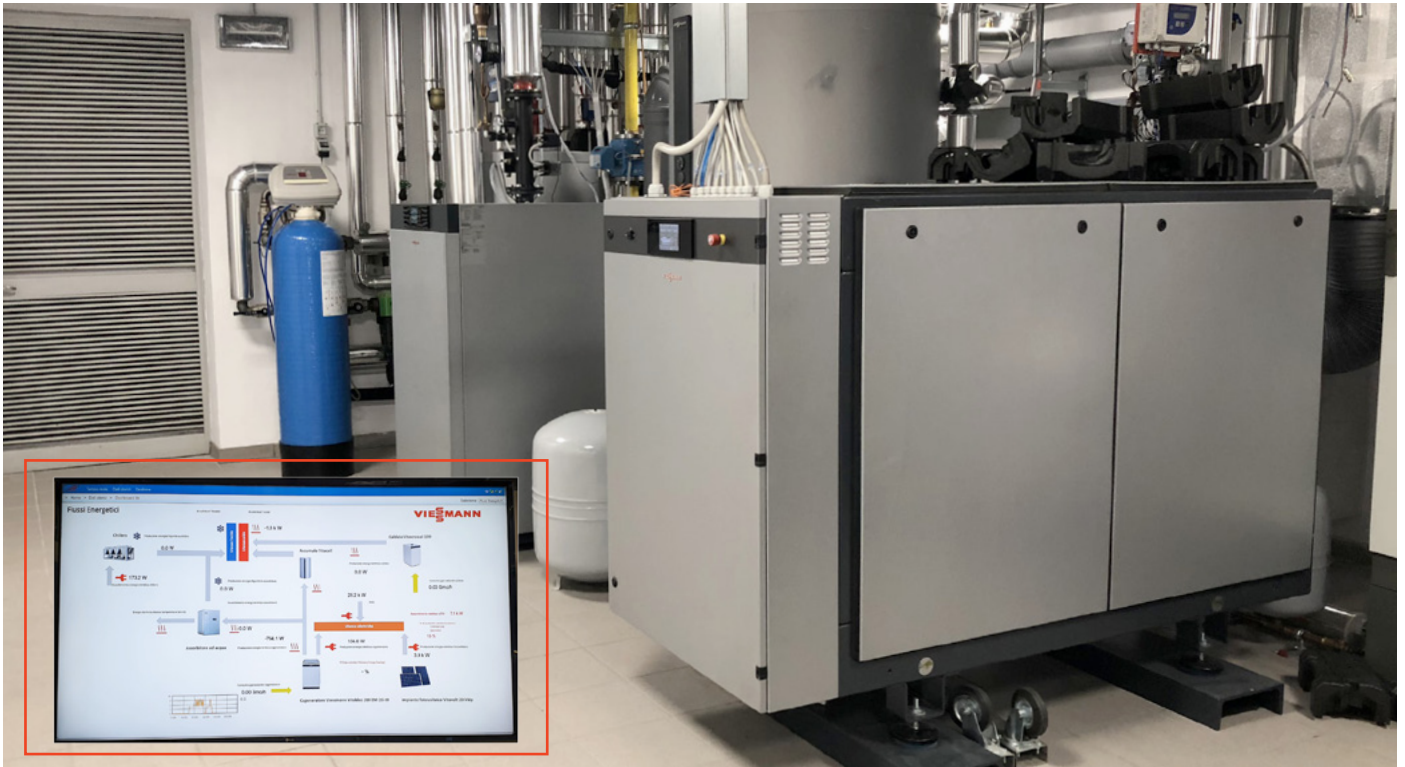
Centrale termica Viessmann della sede di Verona
